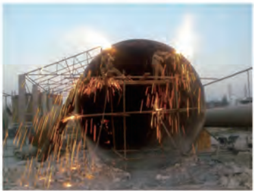
云南公司-质管部-徐猛：技改现场
