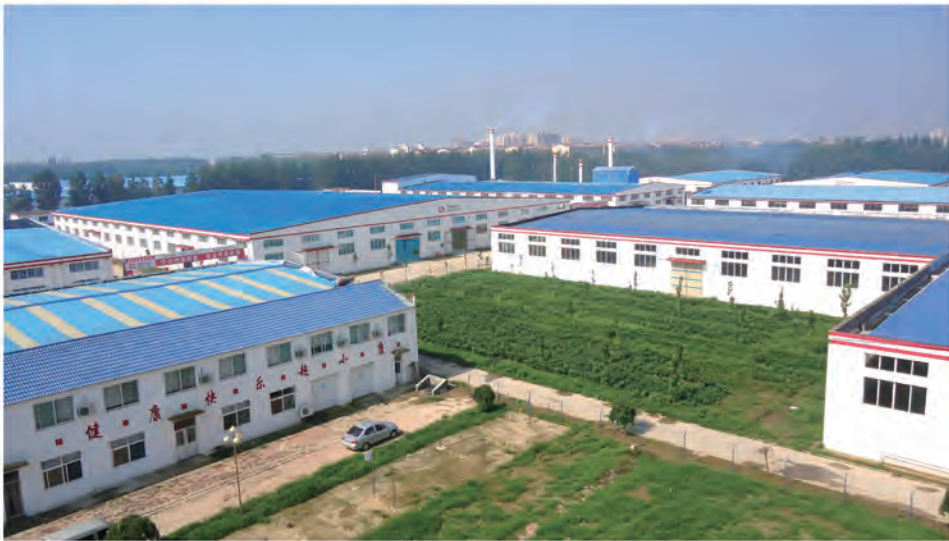
德州公司-质管部-刘明：德州公司一角
