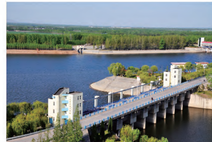
人民胜利堰节制闸—大官庄水利枢纽 作者：倪天华
