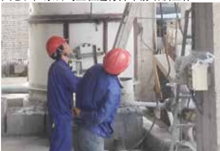
△云南常青树基地，工人正在检修设备，以保障生产顺利进行。
